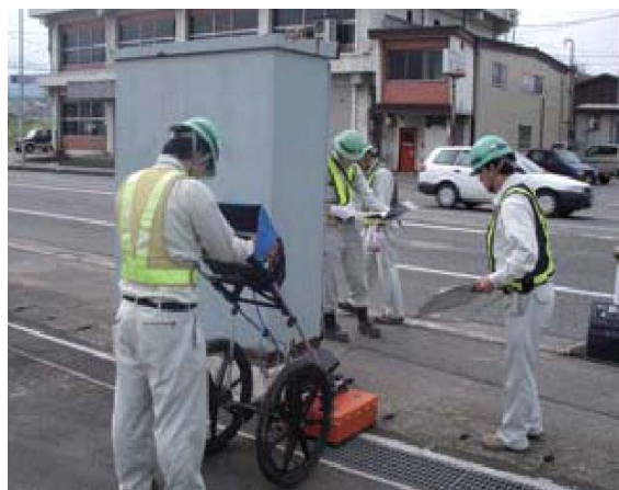
国道での埋設物探査状況
