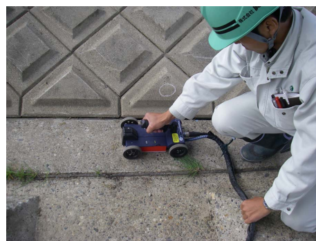
堤防での空洞物探査状況
