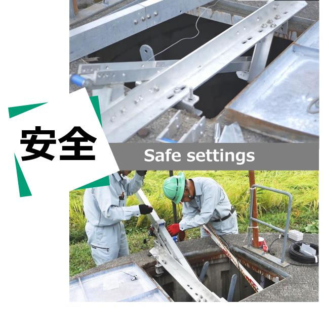
蓋上に乗らずに全ての設置 作業、操作が可能。侵入口2 か所に台座を固定するため、 装置全体が安定します。装 置自体は軽量なため不用意 な転落事故が防止できます。
