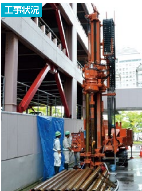
地中熱交換器掘削状況(高速掘削機ソニックドリル使用)
