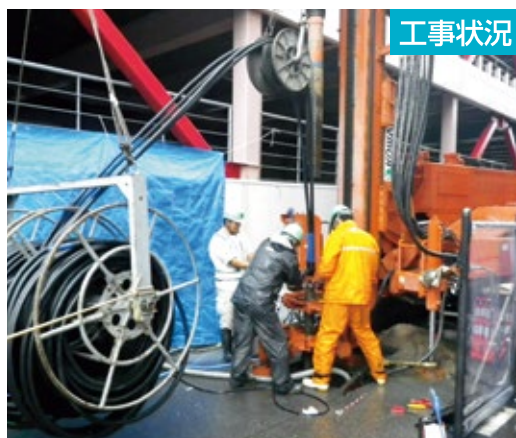
ダブルUチューブ挿入状況(ダイカポリマー社製)
