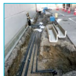
地中熱交換器 接続配管状況
