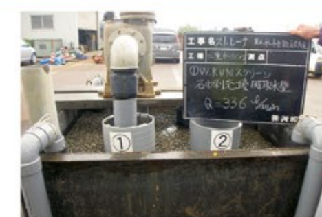
取水性能試験の様子
