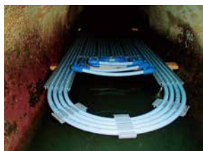
採熱管設置状況
