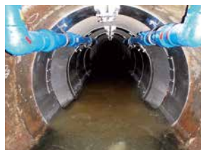
ヘッダー部設置状況
