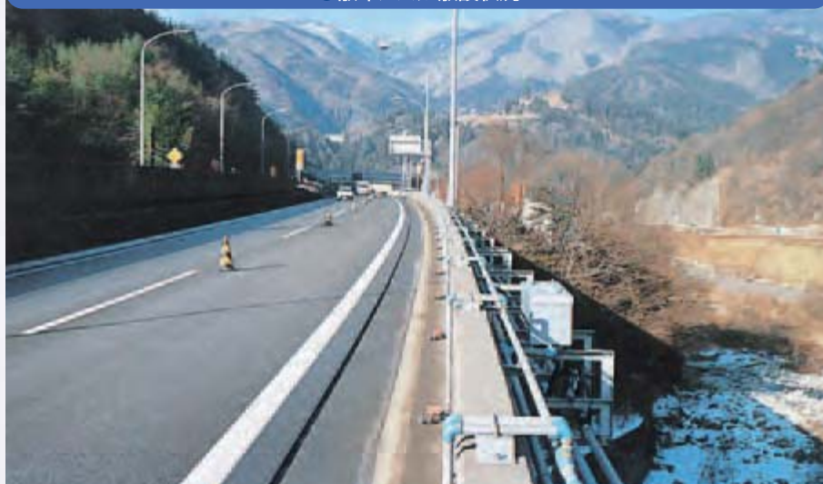
● 散布ノズル敷設状況
