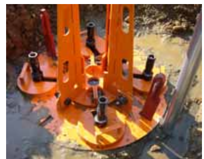
スクリュアンカー設置状況
