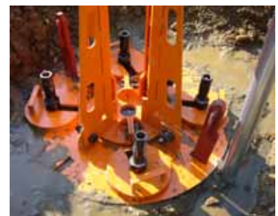
スクリュースクリューアンカー設置状況
