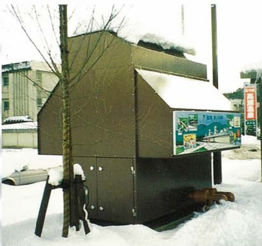
(一般国道113号 道の駅 関川)
