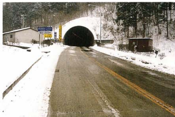
長野県新和田トンネル坑口
