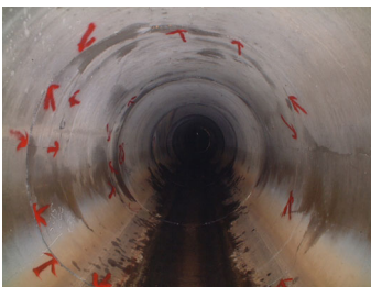
施工前管内状況
