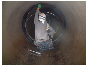
内面バンド搬入設置
