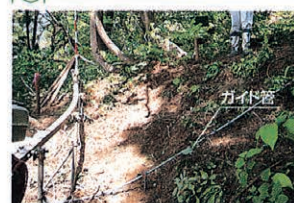
D ガイド管へCFCCの挿入
