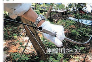
D ガイド管へCFCCの挿入
