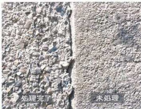
下地処理完了 (WJ工法)
