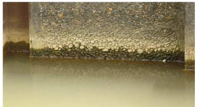
コンクリート表面劣化状況
