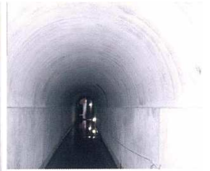
導水路トンネル
