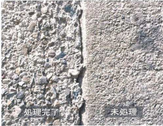
下地処理完了 (WJ工法)
