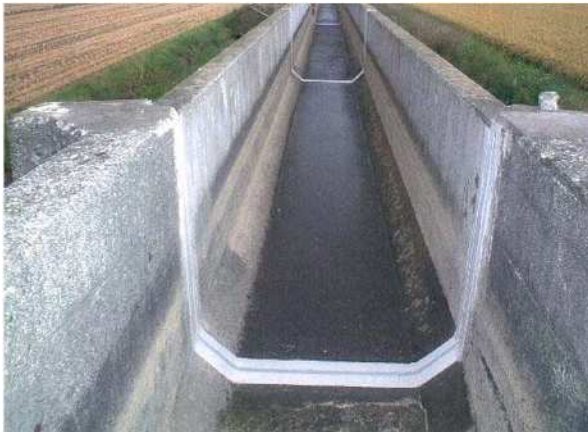
目地補修完了
