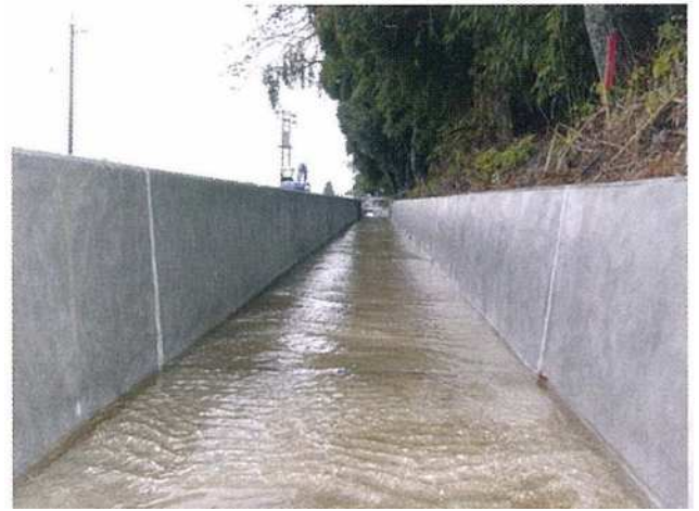
開水路 韌性モルタル完了
