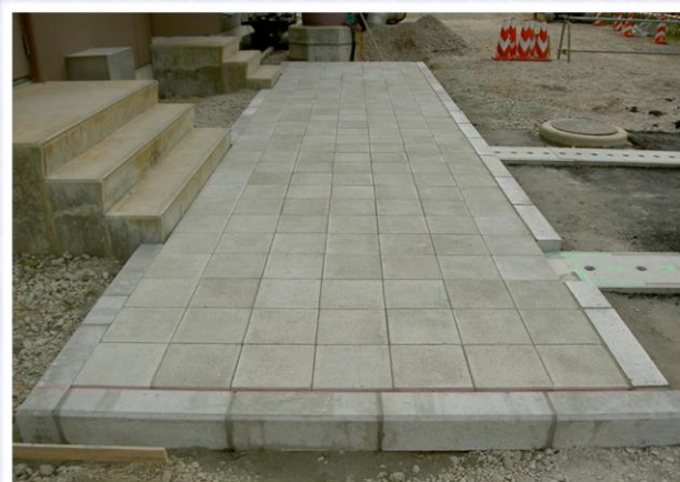
2. ダクト付タイル敷設
