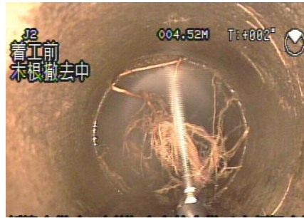
前処理作業(木根除去)
