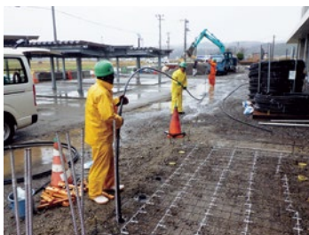
② ヒートパイプ挿入
