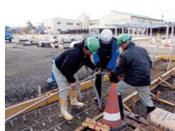
③ ヒートパイプ据付作業状況
