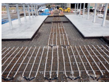
④ ヒートパイプ据付完了
