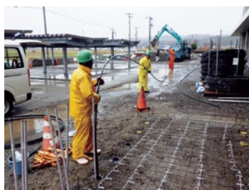
② ヒートパイプ挿入
