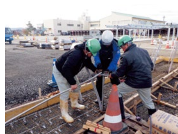
③ ヒートパイプ据付作業状況
