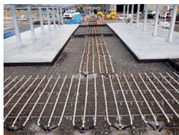
④ ヒートパイプ据付完了
