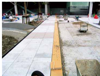
④ コンクリート舗装・平板敷設
