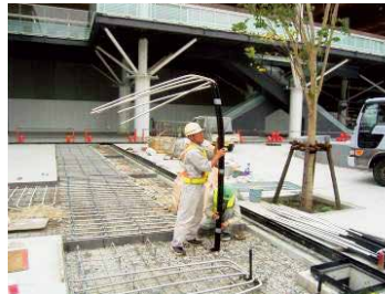
② ヒートパイプ挿入・据付
