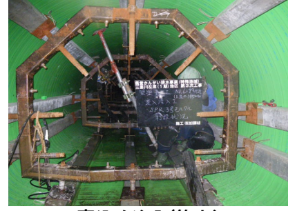
裏込め注入(管内)
