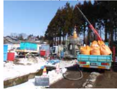
裏込め注入(地上)
