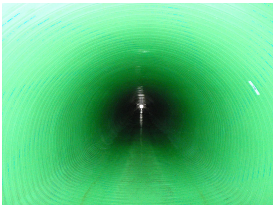
新潟県村上市施工例
