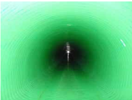
新潟県村上市施工例
