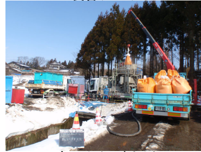
裏込め注入(地上)
