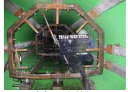
裏込め注入(管内)
