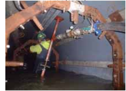
裏込め注入(管内)
