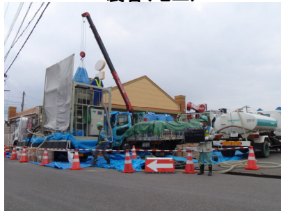
裏込め注入(地上)
