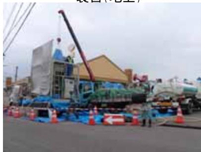
裏込め注入(地上)
