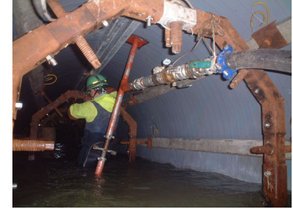
裏込め注入(管内)
