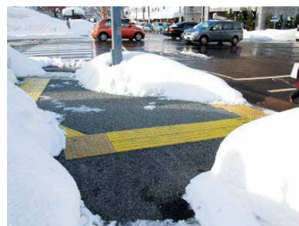
歩道【老朽化井戸再利用】 （新潟県長岡市）
