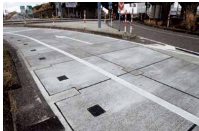
敷設状況(新潟市西区 新通IC)
