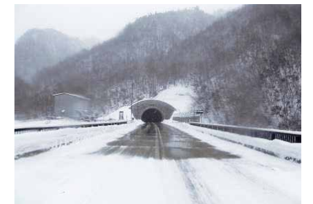
福島県下郷町【トンネル湧水】 （甲子トンネル）
