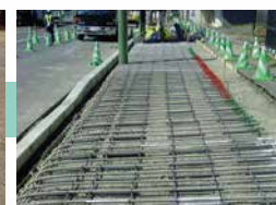
放熱部ヒートパイプ敷設状況
