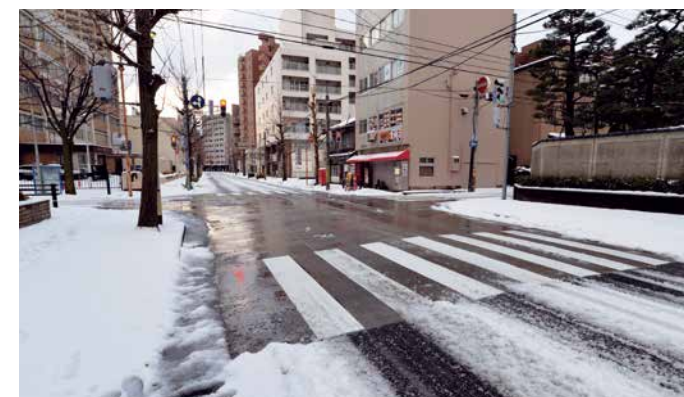
融雪部全景(車道部204m) 新潟市中央区寄居町 新潟小学校前・車道交差点内
