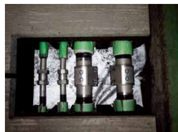
配管接続状況
