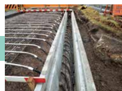
側溝型の採熱部
