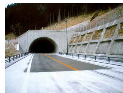
トンネル坑口付近 (岩手県釜石市 甲子TN)
