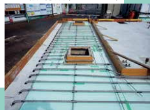
放熱部ヒートパイプ敷設状況
