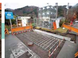
放熱部ヒートパイプ敷設状況
