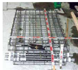
配筋・配管状況
