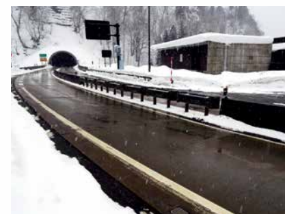
トンネル坑口付近 (山形県真室川町 主根坂TN)
