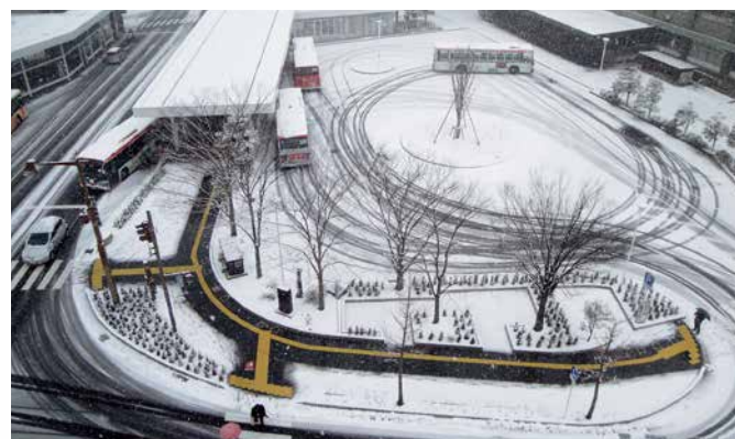
融雪部全景(歩道部108m) 新潟市役所前 バスターミナル歩道
