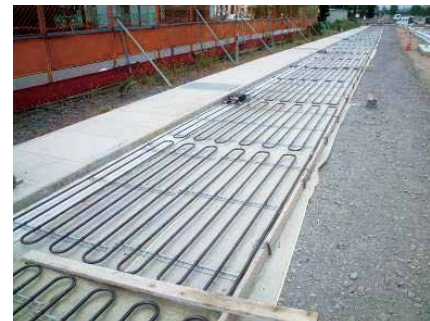
放熱管の敷設状況
