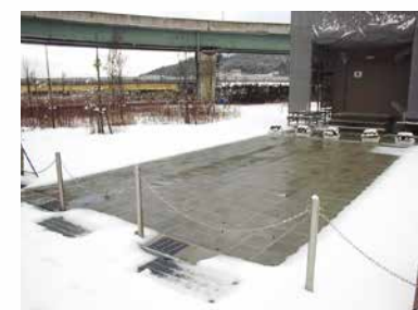
融雪状況(融雪機械室前)
