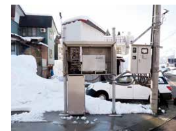
地中熱ヒートポンプ収納状況
