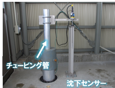
設置例② 新規地盤沈下観測井
