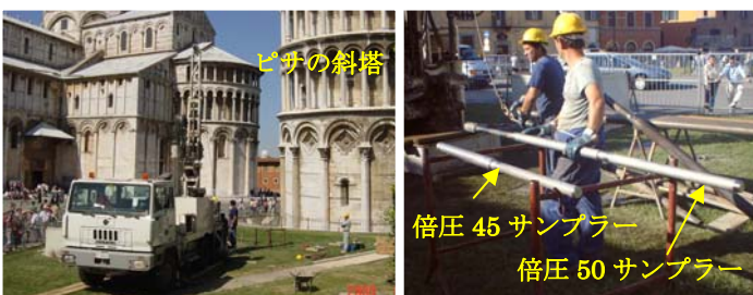
Pisa 粘土のサンプリング (イタリア ピサに於いて)
