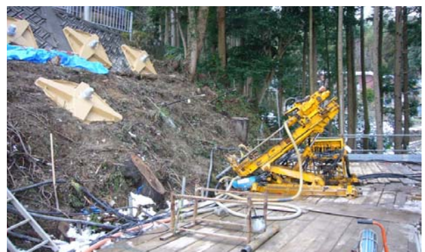
図-4.グラウンドアンカーの削孔管理適用例(大型RPD+大型ビット)
