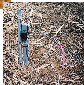
地表傾斜センサーとしての施工例
