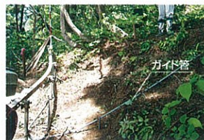
DI ガイド管へCFCCの挿入
