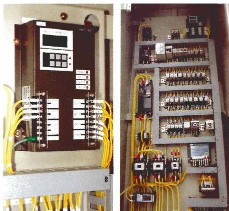
(制御盤内取付状況)
