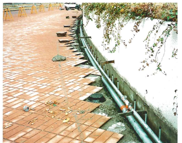
送・湧水管の配管状況
