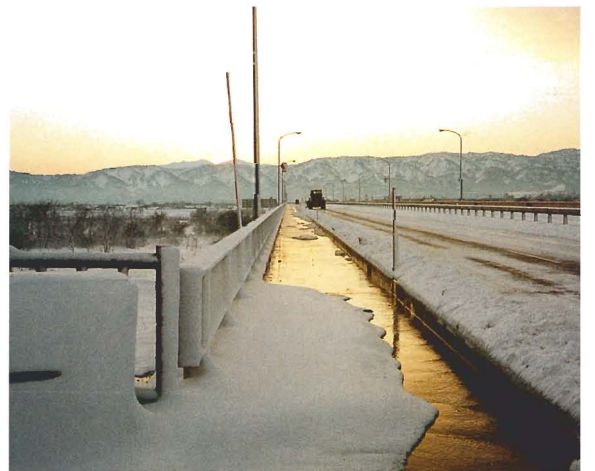
橋梁部における融雪状況
