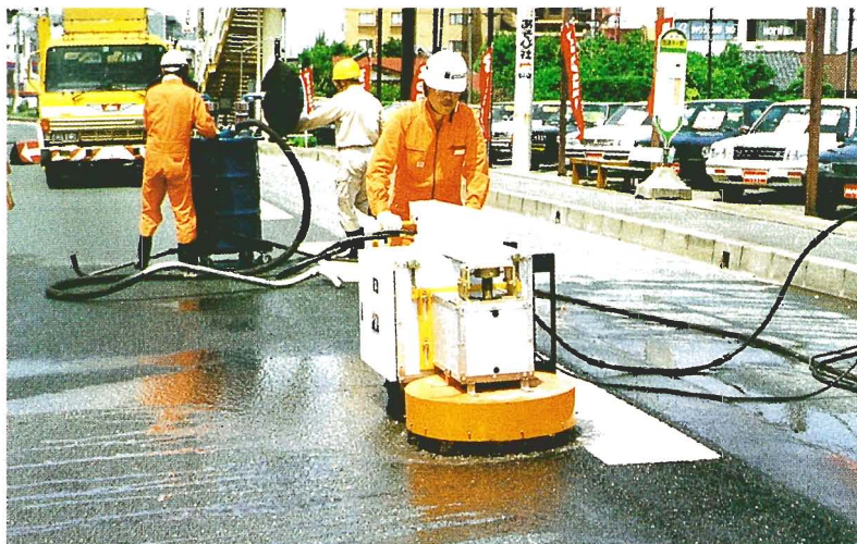
〈 レップ REPPによる目詰り洗浄作業状況〉
