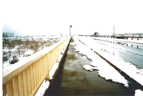
長岡市長岡大橋
