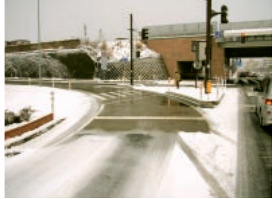
車道（新潟県新潟市 国道7号 弁天IC）
